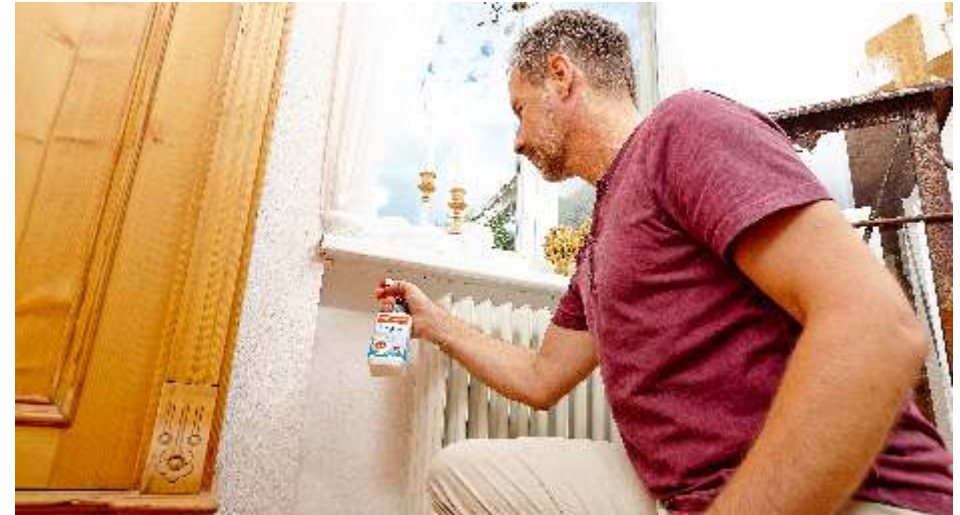
Versteckter Schimmel in der Wohnung ist eine ernstzunehmende Gefahr für die Gesundheit - richtiges Lüften und eine regelmäßige Kontrolle minimieren das Risiko. Foto: djd/Mellerud/Marco Rothbrust
