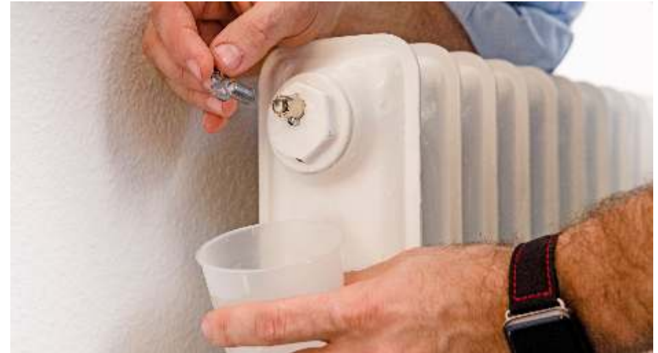
Heizkörper müssen regelmäßig entlüftet werden, sonst verursachen sie neben störenden Gluckergeräuschen auch unnötig hohe Heizkosten. Foto: djd/Techem Energy Services/Bernd Roselieb
